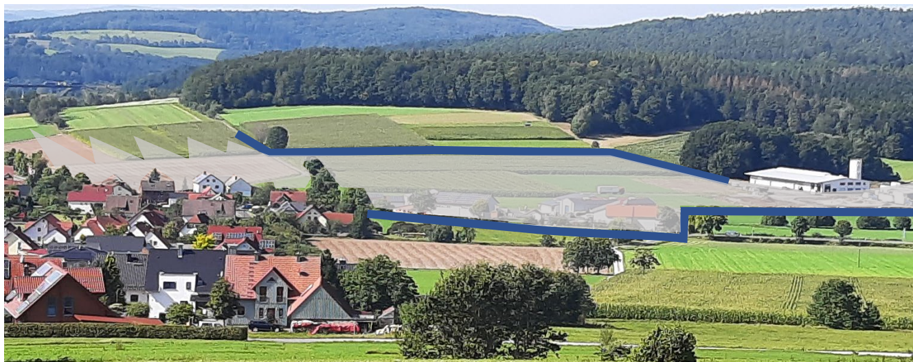
Lage des Entwicklungsgebietes zwischen Ortslage (links) und nördlichem Bestand (rechts im Bild) sowie zwischen Altbestand (Bildmitte) und nordwestlicher Begrenzung (blaue Linien).
